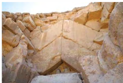
クフ王のピラミッドのシェブロン （良質な石灰岩で構成された切妻構造と呼ばれる様式）
