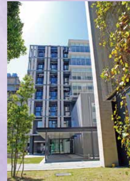
新研究所共同館(入口)
