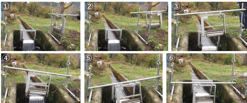
図6 一人作業による水車設置の様子
